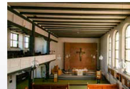
Der Innenraum der St. Johannes-Kirche vor dem Umbau
