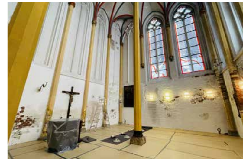
Die Briefkappelle in St. Marien zu Lübeck während der Sanierungsarbeiten
