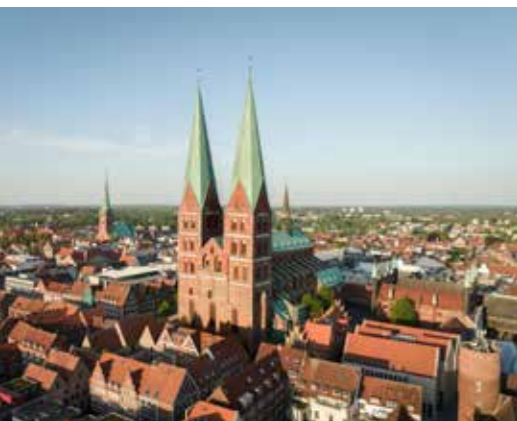
Das grundlegende Problem der St. Marien-Kirche ist die Feuchtigkeit in den Wänden. Hier besteht dringender Sanierungsbedarf.
